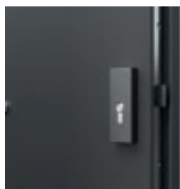
lištový zámok prispôsobený pre dve cylindrické vložky
