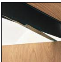
skrytý zatvárač dverí
