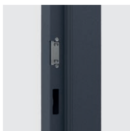
nastaviteľný protiplech zámku
